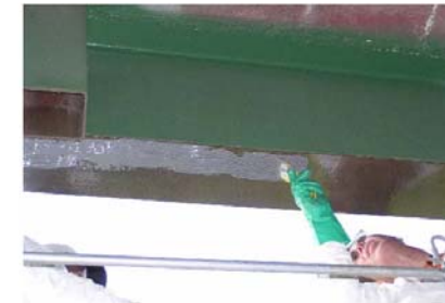
(d) Epoxy application on beam
