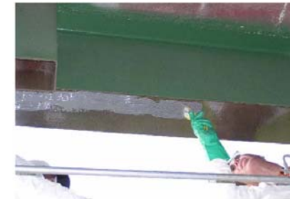
(d) Epoxy application on beam
